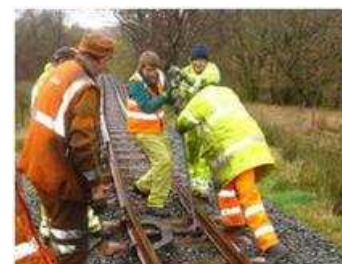
Ré-alignement de joint
