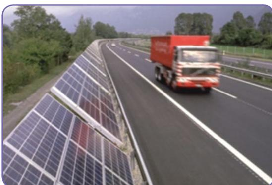
Premier mur antibruit photovoltaïque réalisé en 1989 sur l'A13 © TNC (Source : [www.photovoltaique.info/Murs-antibruit-photovoltaiques.html](http://www.photovoltaique.info/Murs-antibruit-photovoltaiques.html))
