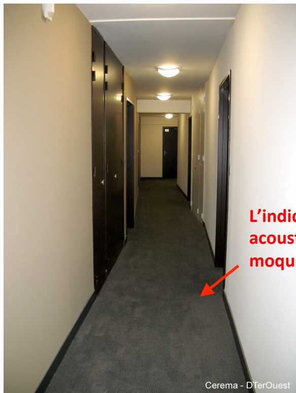
Revêtement absorbant au sol
