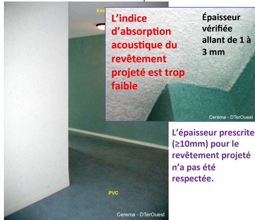
Revêtement absorbant au plafond
