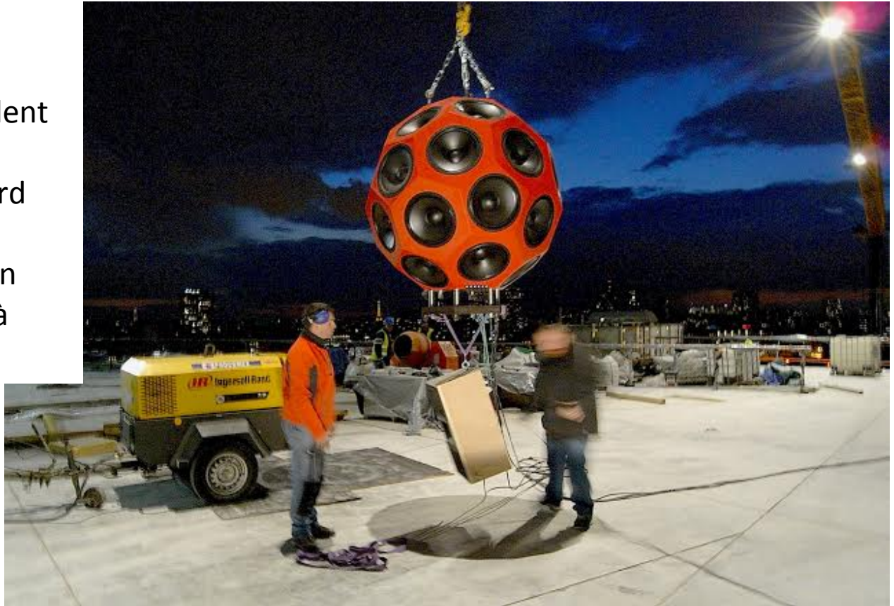
En toiture du « Philharmonique de paris »
