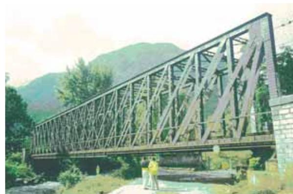
Fig. 5 : Pont métallique à poutres latérales hautes
