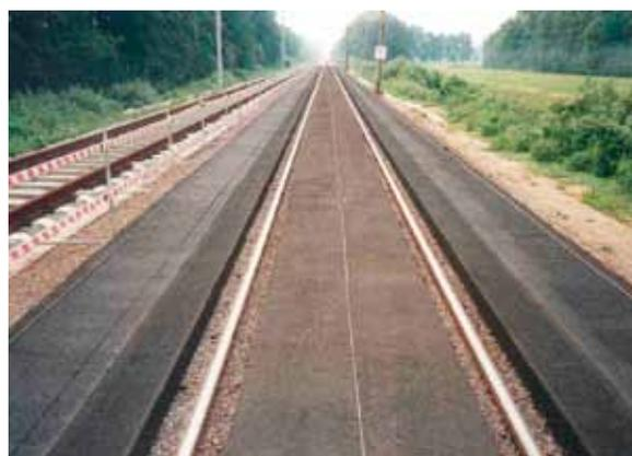
Fig. 10: Étude de l'absorption maximale possible d'une voie sur dalle avec utilisation de la limite de gabarit d'espace libre (absorbeur en caoutchouc recyclé)
