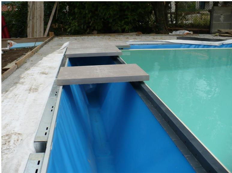
Les goulottes trapézoïdales ou semi-trapézoïdales
