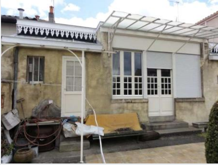
Photo : façade exposée à la voie ferrée
