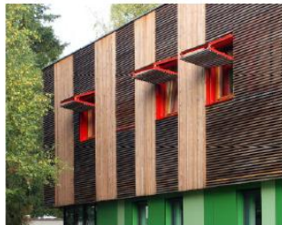
PANNEAUX AJOURÉS COULISSANTS, Bureaux, St-Martin d'Hères, (arch : Unanime Alpes)
