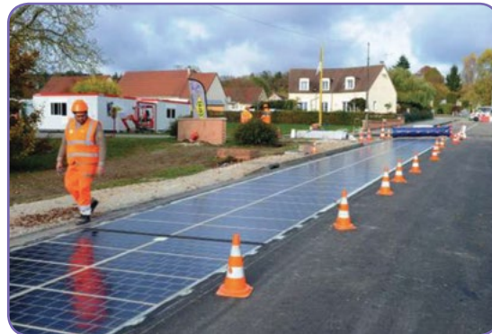
Installation de la route solaire à Tourouvre (61) © SOULABAILLE Y./WATTWAY
