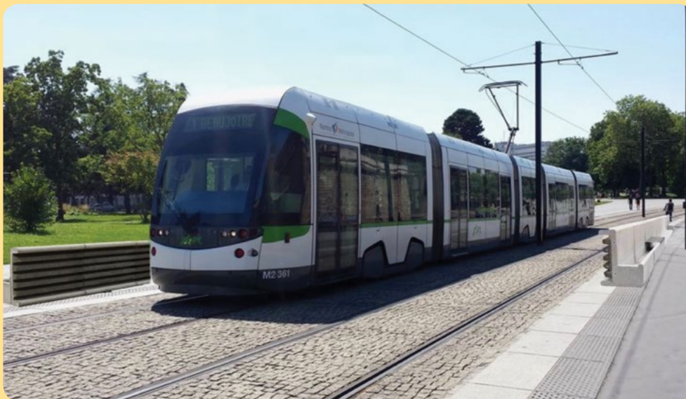
Figure n°8 : Montage photographique d'un mur bas (prototype PBM) le long du tramway de Nantes (© PBM Groupe)
