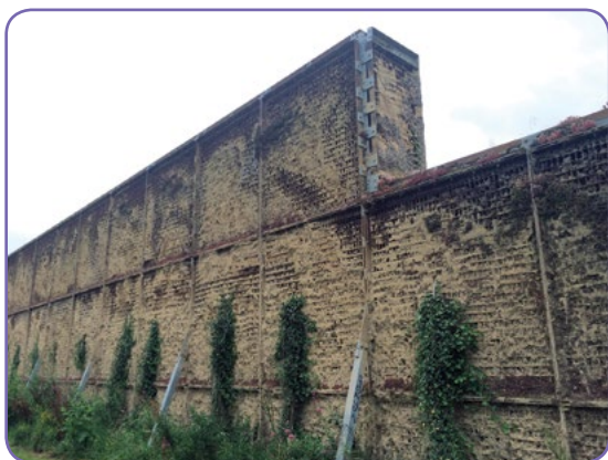
Parc des Alisiers à Antony (92) : mur antibruit composé de morceaux de pouzzolane encagés (Source : CidB)
