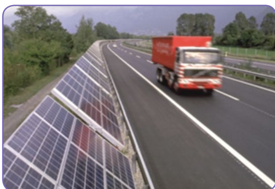
Premier mur antibruit photovoltaïque réalisé en 1989 sur l'A13 © TNC (Source : www.photovoltaique.info/Murs-antibruit-photovoltaiques.html )
