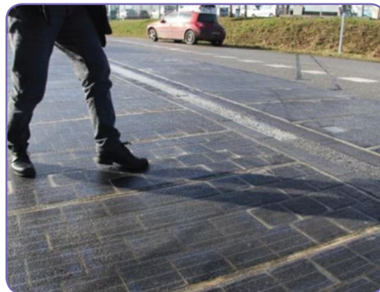
"Pavés" photovoltaïques devant le collège de Belleville-sur-Vie (85) © Ouest-France
