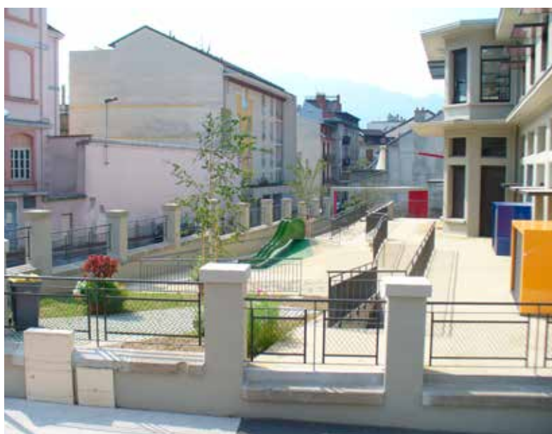
La proximité de logements d'habitation a nécessité une attention particulière par rapport au bruit généré par la pompe à chaleur.
