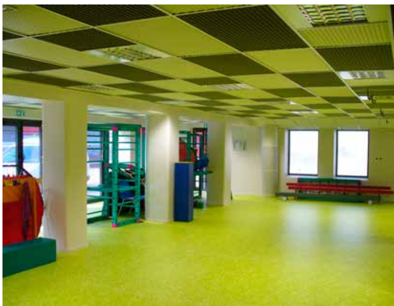
Dans les classes, les dalles suspendues forment une voûte, qui améliore l'acoustique et réfléchit la lumière naturelle
