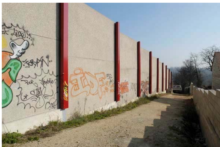
Illustration 14 - Arrière de protections acoustiques sur l'autoroute A6 à Savigny-sur-Orge (DREIF/GOBRY)
