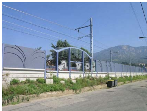
Illustration 11 - Exemple d'intégration par un travail sur la forme et le dessin d'un écran acoustique – Aix-les-Bains (RFF)
