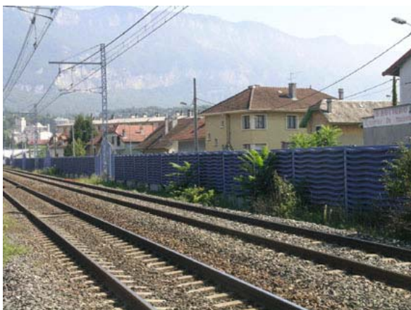
Illustration 11 - Exemple d'intégration par un travail sur la forme et le dessin d'un écran acoustique – Aix-les-Bains (RFF)
