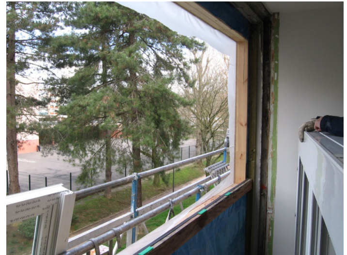
3 - Pose de la nouvelle menuiserie
