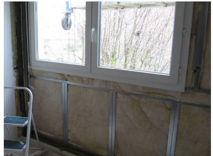
4 - Pose de l'isolation
