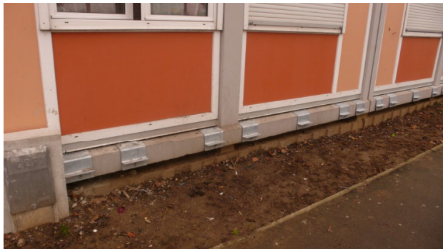
1 - Préparation et fixation de pattes
