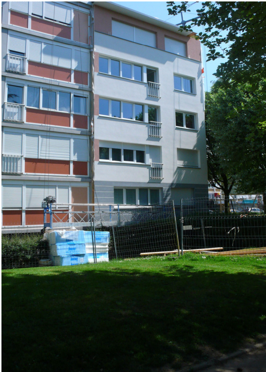
Nouvelle façade, requalification de l'immeuble
