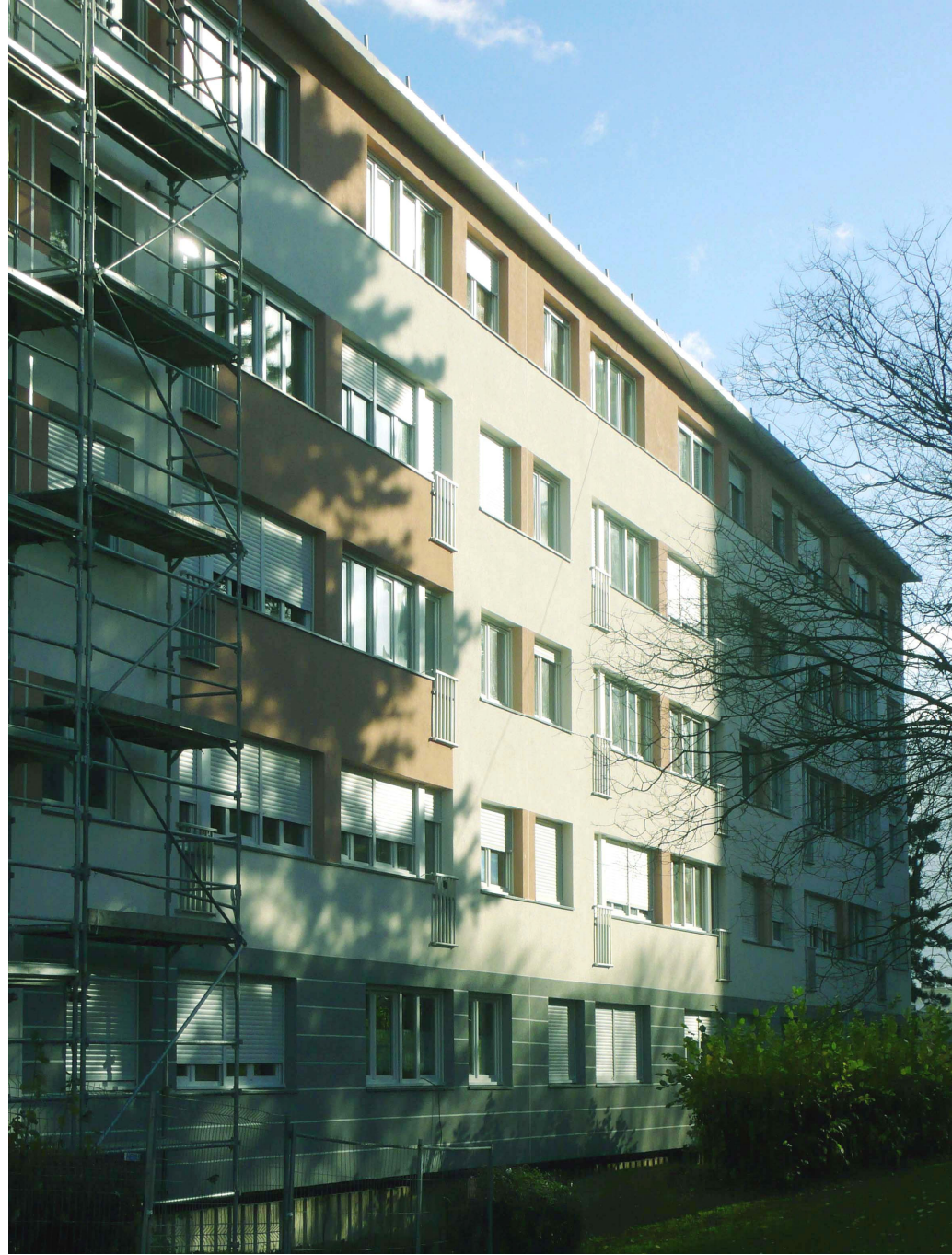
Façade extérieure réalisée
