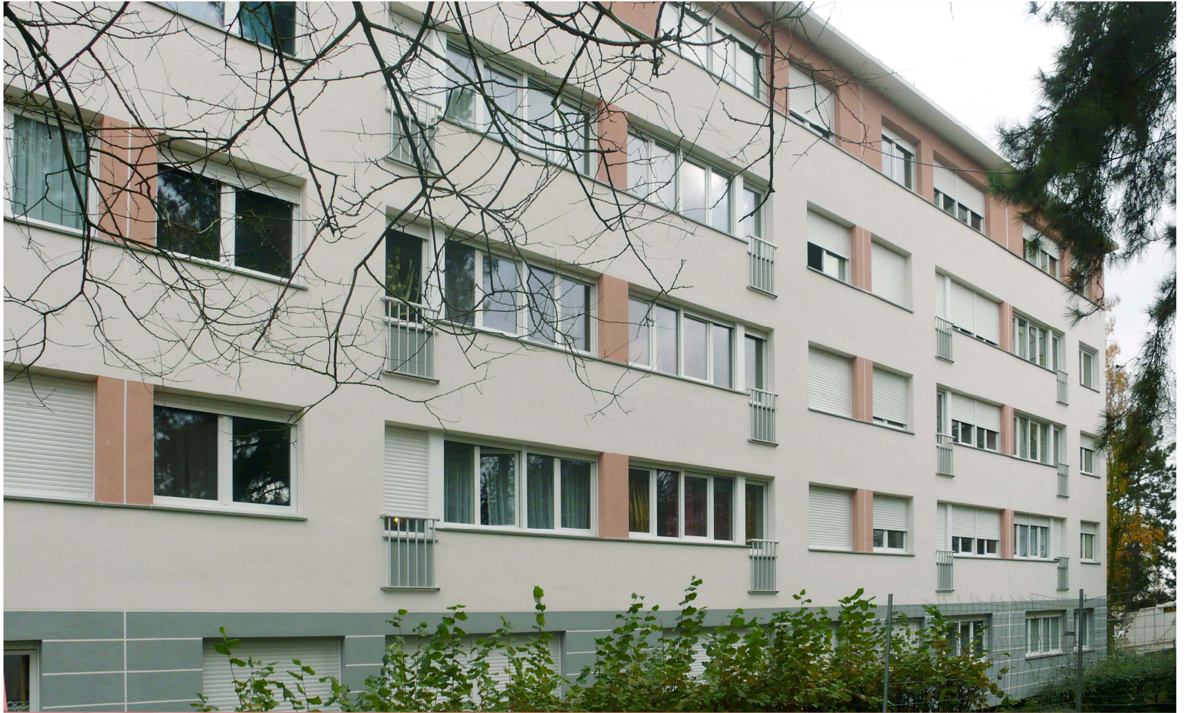
Façade extérieure réalisée
