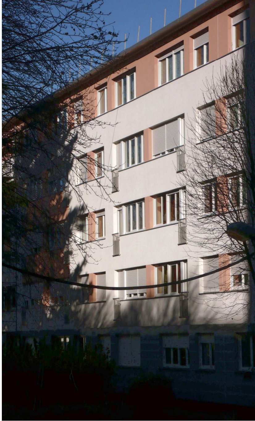
Façade extérieure réalisée
