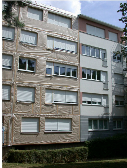
5 - Panneaux en bois posés en attente de l'isolation extérieure
