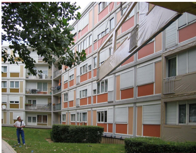
2 - Pose des panneaux en bois
