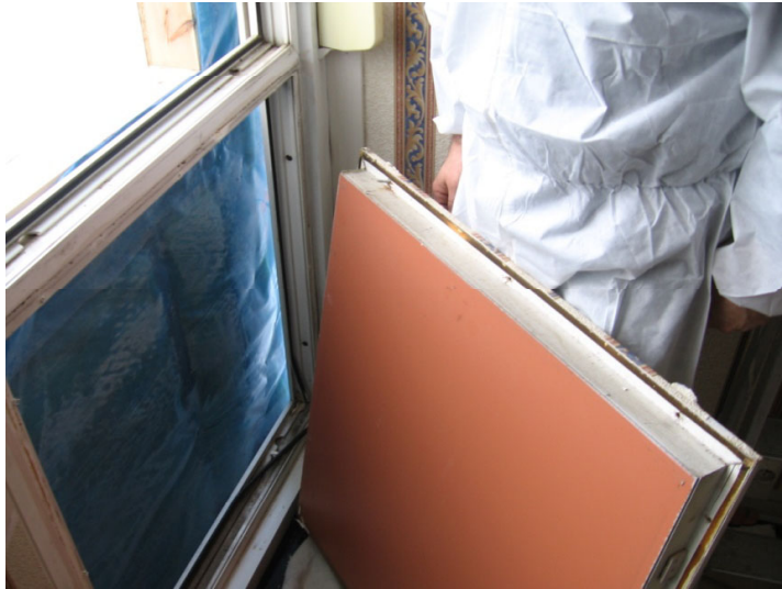
1 - Dépose de l'ancien panneau intérieur amianté
