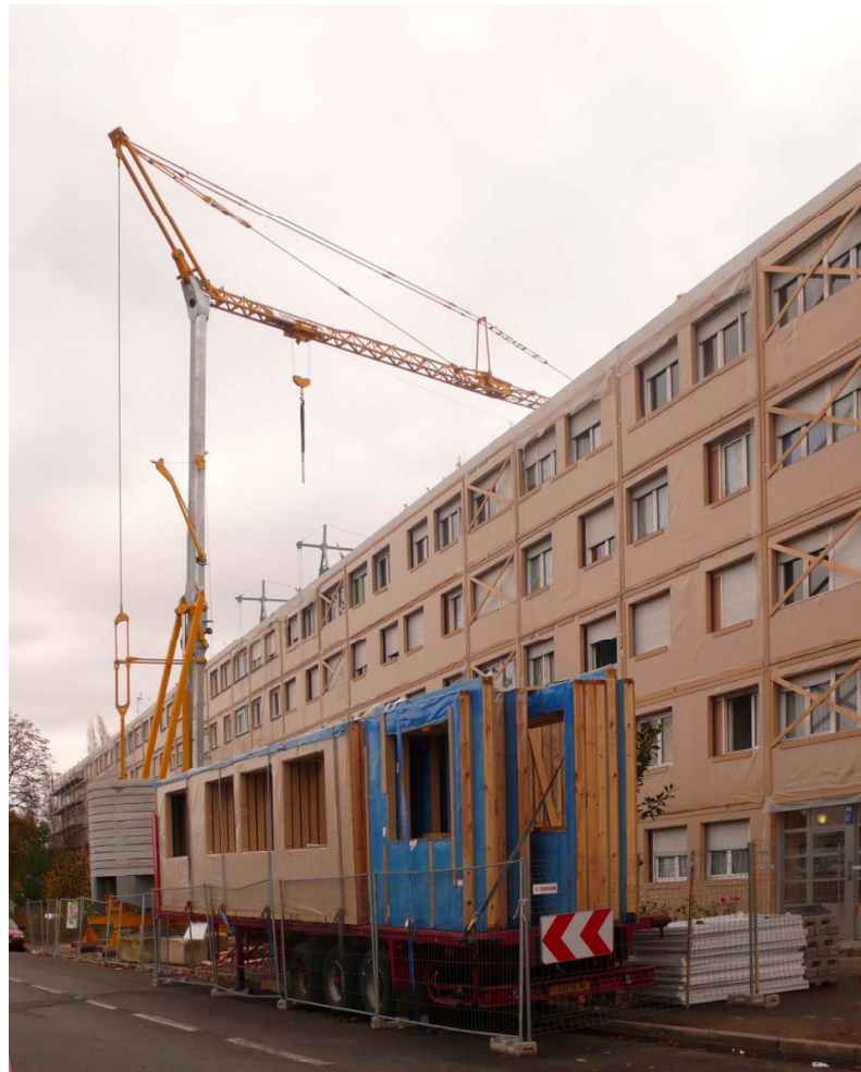
3 - Panneaux en bois posés en attente de la dépose des menuiseries
