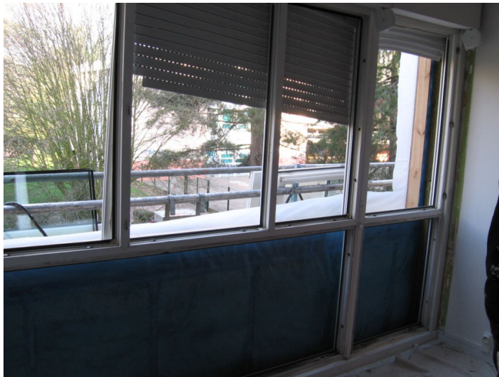
2 - Dépose ancienne menuiserie
