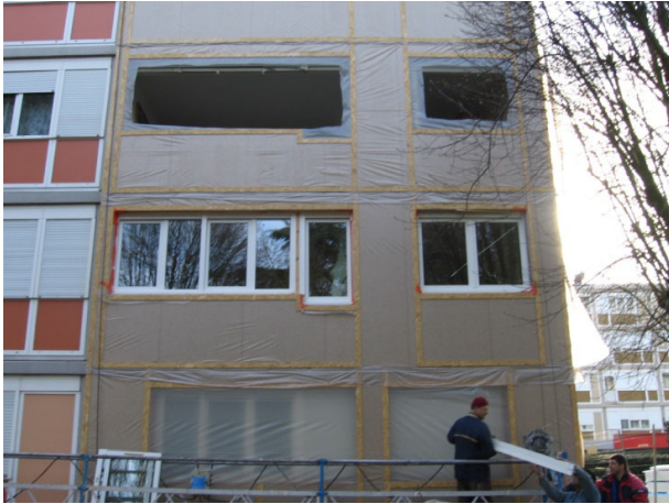
4 - Dépose des anciennes menuiseries et pose des nouvelles.
