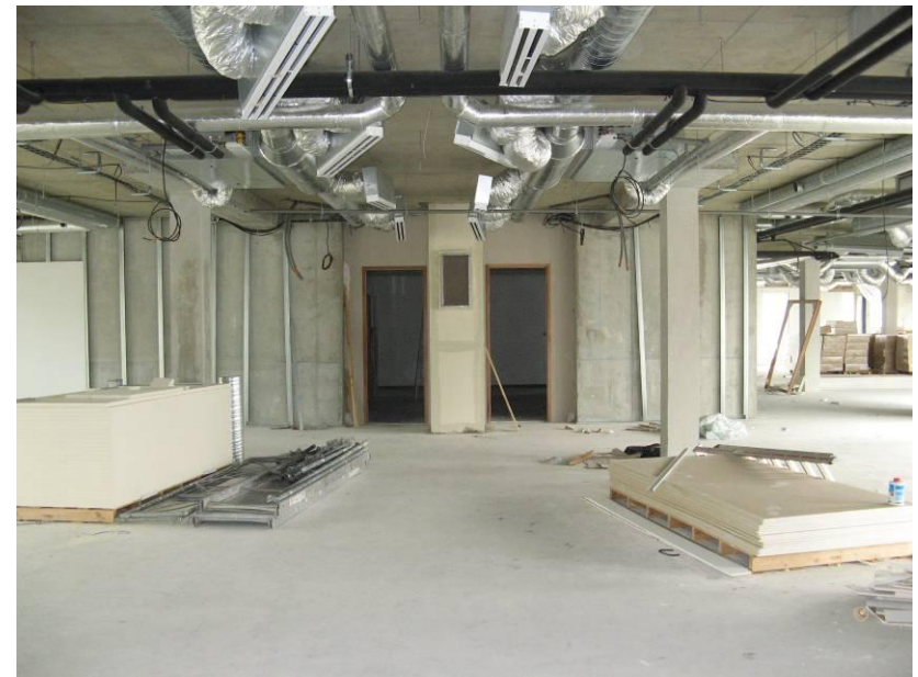
Bouches de soufflages et reprise en faux plafonds : régulation par boucles de 100 m 2
