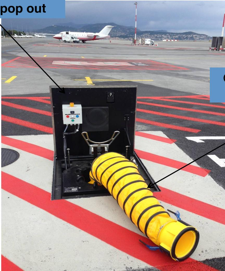
**Gaine rétractable pour l'air conditionné**
