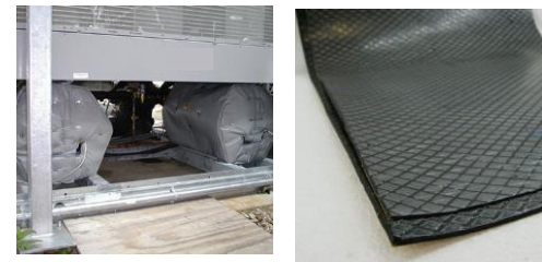
Réduction du rayonnement / Renfort d'isolation des parois
