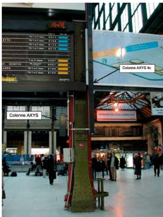
Fig. 4 : colonnes à contrôle de directivité numérique AXYS Intellivox de la Gare de Lyon (accroche provisoire)
