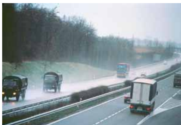
Photo 2 : Réduction des projections d'eau sur chaussée revêtue par des enrobés drainants
