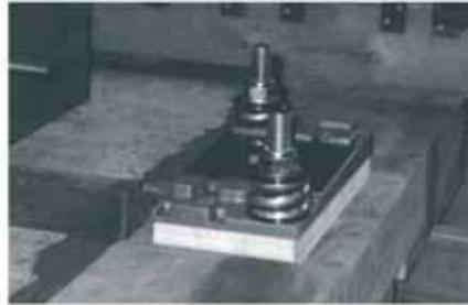
Fig. 1 : Système de fixation précontraint D2S avec semelle sous selle
