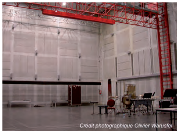
Fig. 10 : Vues de l'installation en cours de montage et achevée. En haut : Passage des câbles dans le plenum de l'ESPRO et installation des haut-parleurs du plafond. En bas : Murs Est et Sud montrant les réseaux linéaires pour la WFS et quelques haut-parleurs HOA
