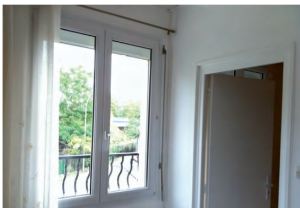
Fig 4 : Une menuiserie changée récemment mais sans d'entrée d'air !
