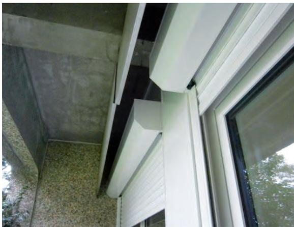
Fig. 6 : Blocs-baies mis en œuvre : vue intérieure et extérieure
