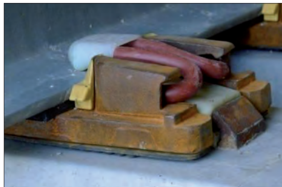
Fig. 6 : Système d'attache DFC (Double Fast Clip) ou DFC VIPA © Pandrol Rail fastening system DFC (double Fast Clip) or DFC VIPA © Pandrol
