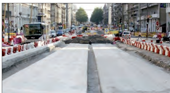
Fig. 1 : Dalle de tramway de Grenoble (38) - Cours Jean Jaurès Tramway slab in Grenoble (38) – Cours Jean Jaurès
