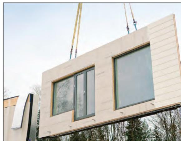
Fig. 4 : Panneau de façade préfabriqué en CLT (doc. Stora Enso)
