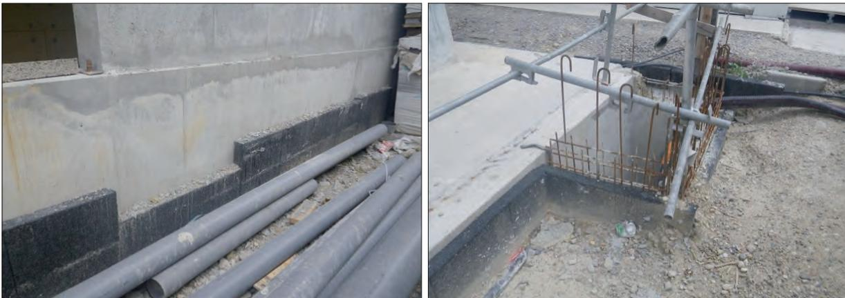
Fig. 14 : Vues de la mise en œuvre du matelas résilient
