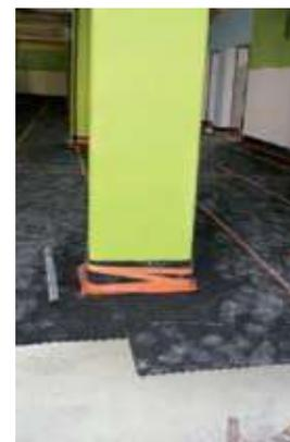
Fig. 4 : Mise en place de sous-couche de dalle flottante
