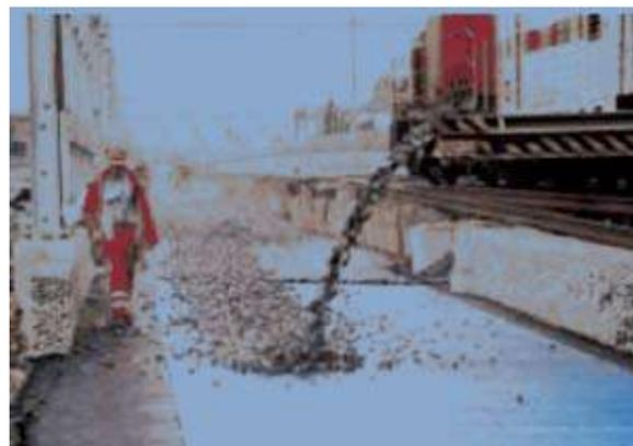
Fig. 5 : Pose d'un tapis sous ballast lors d'un renouvellement complet d'une voie
