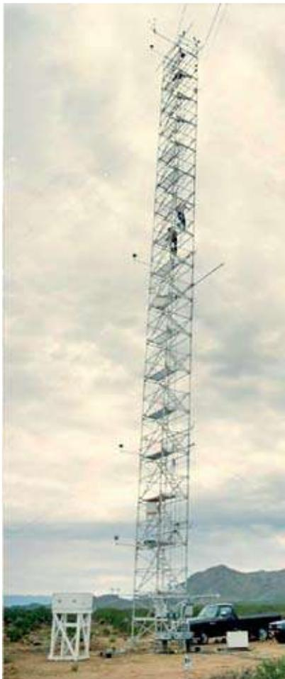
Fig. 5 : Mât instrumenté de 32 m (photographie WSMR / expérience OTAN RSG-11)
