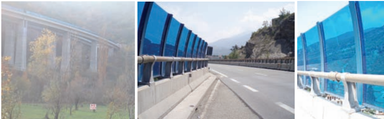
Fig. 6 : Autoroute Turin-Frejus à hauteur de Venaus, dans la vallée de Suse (Italie). Vue du viaduc d'une hauteur d'environ 20 m depuis Venaus (à gauche), vue de la plateforme routière (milieu) et vue de Venaus depuis la plateforme (à droite) avec vision claire de la fente horizontale
