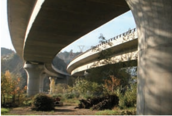
Fig. 8 : Viaduc avec vide central
