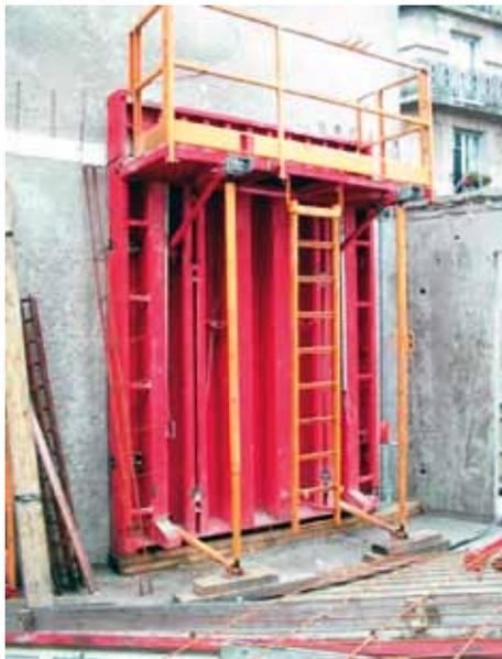
Photo 1 : lors du vibrage du béton, les coffrages métalliques entrent en résonance !
