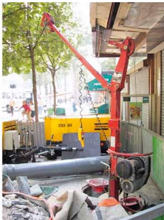
Fig 2: Travaux rue Faure. a: grue thermique. b: grue électrique
